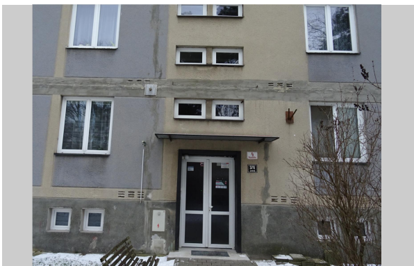
Pohled na vstup do budovy
