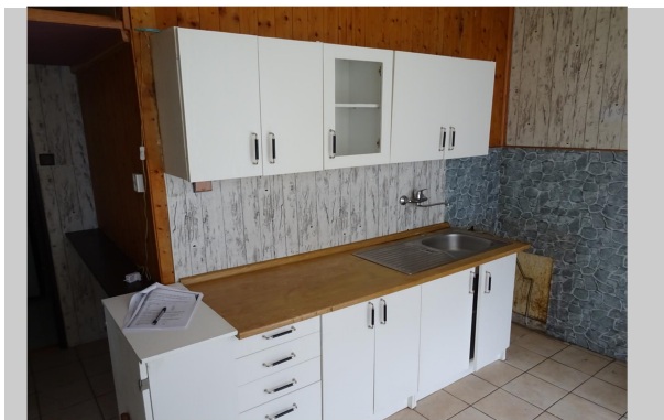
Pohled na část kuchyně bez kuchyňské linky
