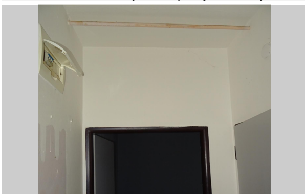
Pohled na část předsíně s předpjatým táhlem
