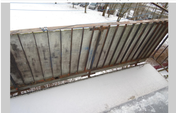
Pohled na balkon z chodby bytové jednotky
